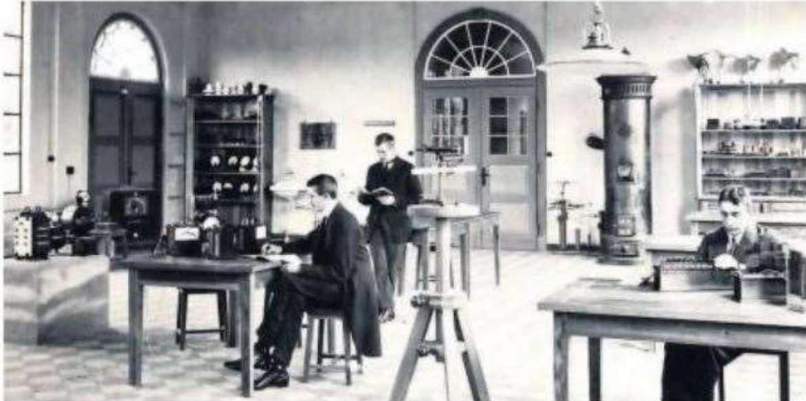
Elektrotechnisches Labor im Laboratorium der Ingenieur-Akademie Wismar um 1910. Foto: Archiv Hansestadt Wismar, Crull-Sammlung 0570
