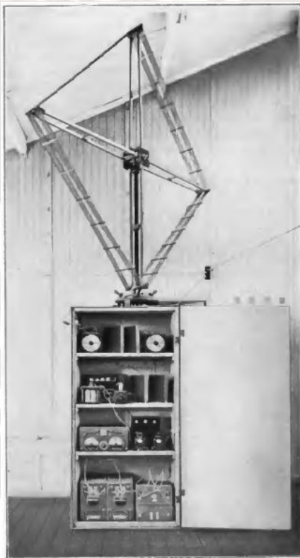
Abb. 55. Einkapselter Zwischenfrequenz-Rahmenempfänger mit abgeblendeter Antenne von Telefunken (Transradio) in Geltow.
