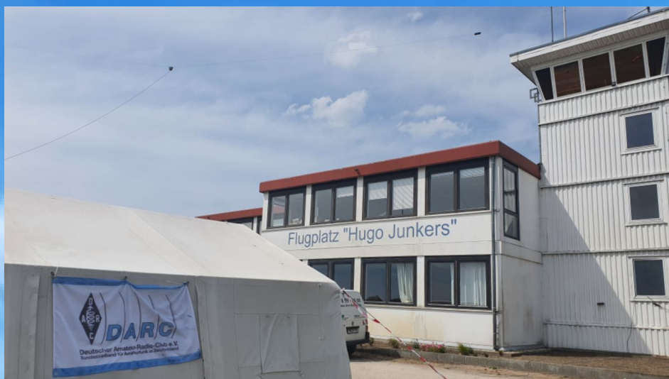
Stationszelt im Vorfeld des Towers, darüber die W3-2000 Antenne hängend (Foto: DL1RUN)
