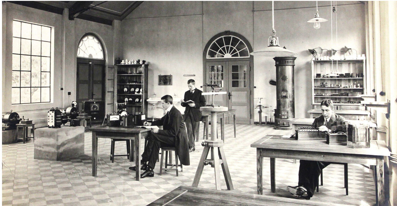
Abb. 4: Elektrotechnisches Labor im Laboratorium der Akademie 1910/1911 (AHW, Crull-Sammlung, 0570).
