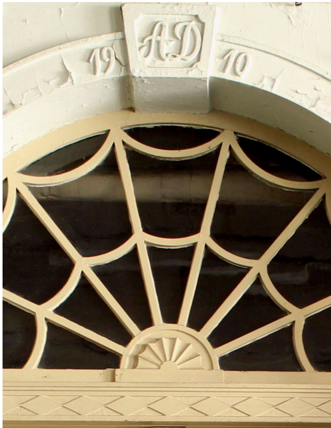
Abb. 3: Details einer Tür im Laboratorium. 1910 eine Außentür am Mittelbau, 1913 der Eingang zum Maschinentechnischen Labor. (Foto: Doreen Piper).
